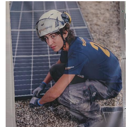
Apprendistato solare - Il tuo futuro è solare - Impara a diventare un installatore solare
