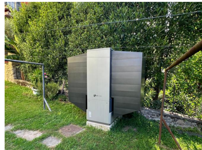
Unità esterna pompa di calore
