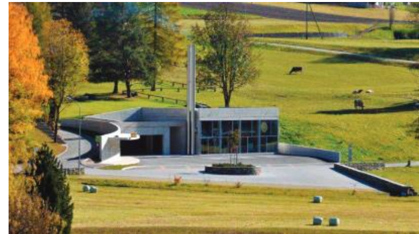
Centrale termica S. Maria Comune di Poschiavo
