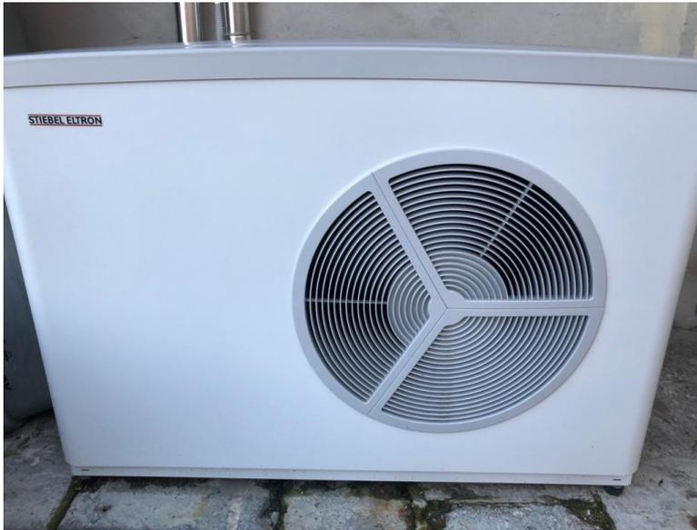
Pompa di calore aria/acqua
